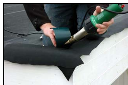
Innenecke verkleben und verschweißen
