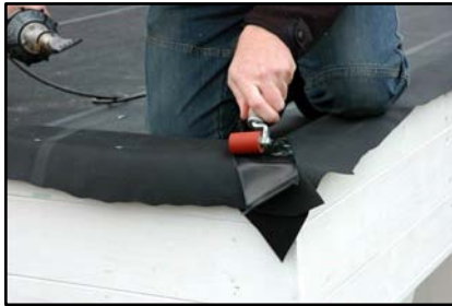
Innenecke verkleben und verschweißen
