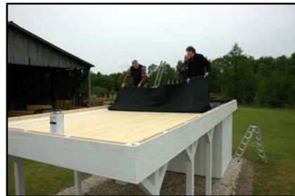
Aufnahme der EPDM-Folie nach einer ca. 30 min. Ruhezeit
