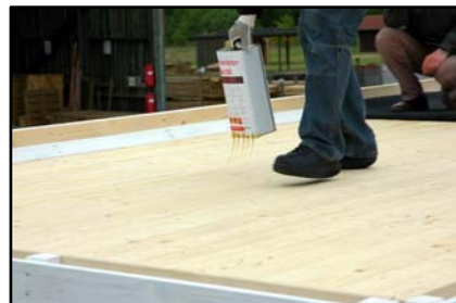
Gleichmäßiges Aufbringen des Klebers
