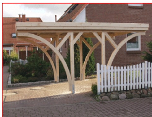
Sondercarport mit 4 Leimholzbögen
