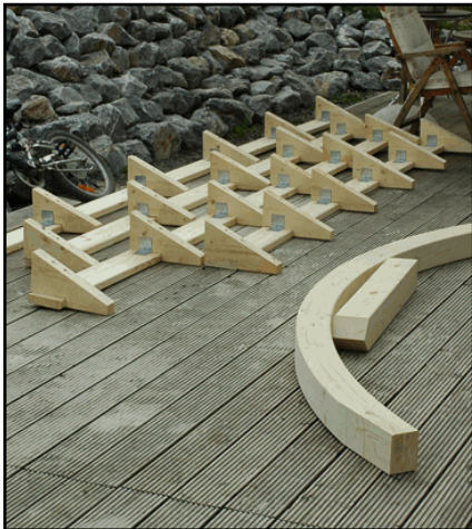
Walmstücke auf der Trägerbohle montiert
