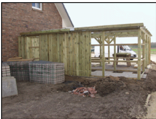
Montage: Geräteraum im DIY Verfahren
