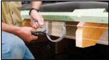
Beispiel der Anwendung der Doppelrichtschnur
