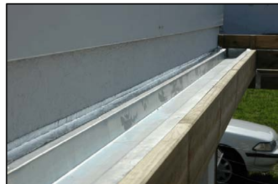
Absicherung des letzten Sparrens mittels eines alu- miniumkaschierten Bitumenbandes
