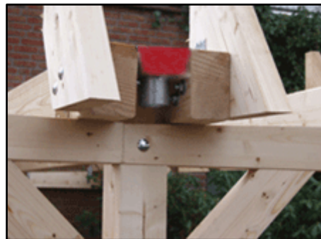
Fallrohrstutzen an der Regenrinne
