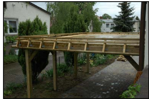
Unterkonstruktion einreihige gewalmte Pfannenblende
