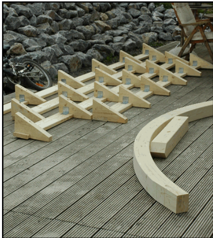
Walmstücke auf der Trägerbohle montiert
