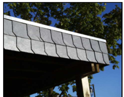
Sparren 95 x 195 mm auf Tragbalken 55 x 175-95 mm
